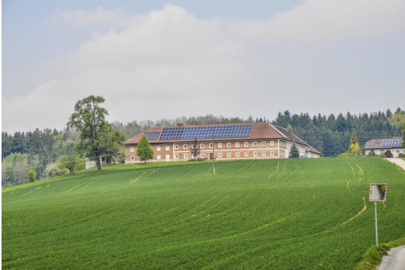
Bild 3: In diesem Geflügelbauernhof in Oberösterreich ist der Salzwasserspeicher GREENROCK Business Teil eines netzgekoppelten Systems mit 72 Kilowattstunden Leistung.
